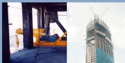
MALACATE de 5 toneladas de capacidad, 250m de izaje, para el montaje de fachadas en la torre mayor (D.F.)
