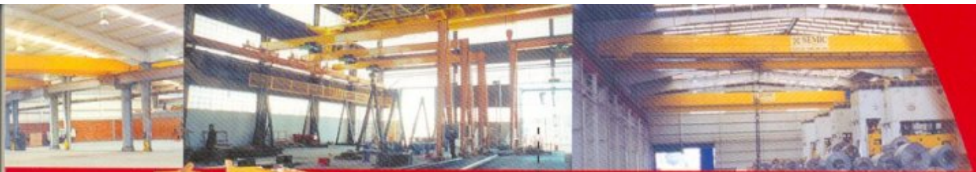
3 grúas viajeras de 50t. de capacidad. 31m. de claro. Puebla, Pue.
