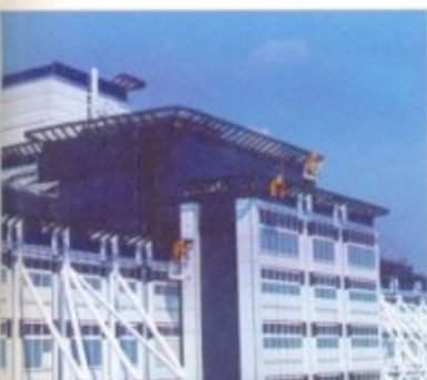
12 canastillas para limpieza de fachadas controladas por mandos remotos. Hospital 20 de Noviembre, D.F.
