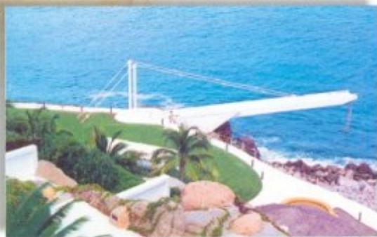
Muelle elevado con rampa eléctrica. Acapulco, Gro.
