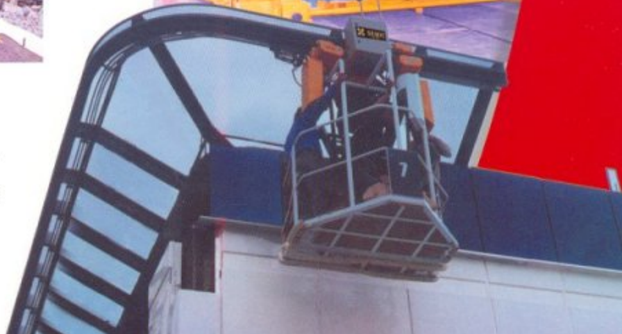
12 canastillas para limpieza de fachadas controladas por mandos remotos. Hospital 20 de Noviembre, D.F.
