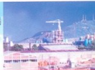
Grúa Torre de 25t. de capacidad a 8m. y 5t. a 36m. con 65m. de izaje
